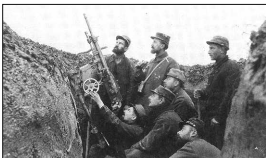
DOCUMENT 2 – Mise en place d'une batterie antiaérienne en février 1915.
